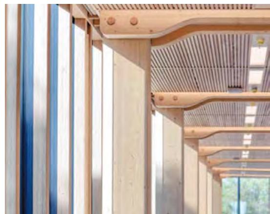
شکل ۱: مواد زیست‌پایه؛ چسب ساختمانی Henkel برای چوب‌های باربر در پروژه Bjergsted Financial Park در نروژ به کار گرفته شد
